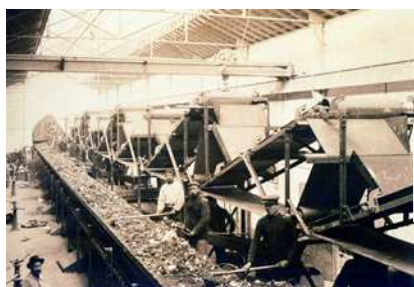
Hall des broyeurs à Vitry sur Seine : des ouvriers attirent la gadoue dans la trémie placée au-dessus de chaque broyeur.
