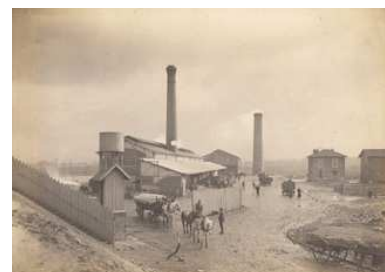
Usine de broyage et d'incinération de Romainville construite en 1905
