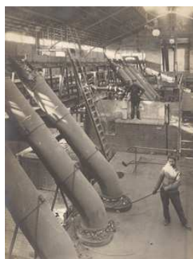
La gadoue est acheminée par un transporteur et aiguillée par des ouvriers pour remplir les goulottes d'alimentation des fours. Quatre portes sont percées dans la façade de chaque four et permettent aux ouvriers d'opérer l'étalage de la gadoue et d'enlever les mâchefers
