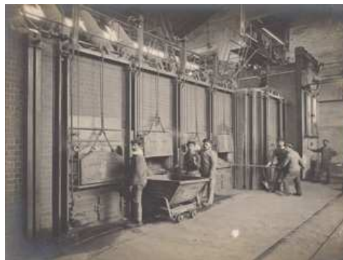
La gadoue est acheminée par un transporteur et aiguillée par des ouvriers pour remplir les goulottes d'alimentation des fours. Quatre portes sont percées dans la façade de chaque four et permettent aux ouvriers d'opérer l'étalage de la gadoue et d'enlever les mâchefers
