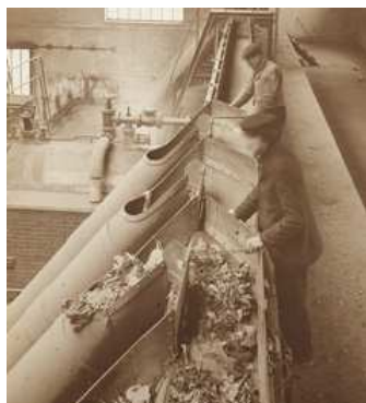
La gadoue est acheminée par un transporteur et aiguillée par des ouvriers pour remplir les goulottes d'alimentation des fours. Quatre portes sont percées dans la façade de chaque four et permettent aux ouvriers d'opérer l'étalage de la gadoue et d'enlever les mâchefers
